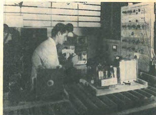
Qui sotto: il wobblatore descritto in funzionamento per la taratura a catena di ricevitori.
